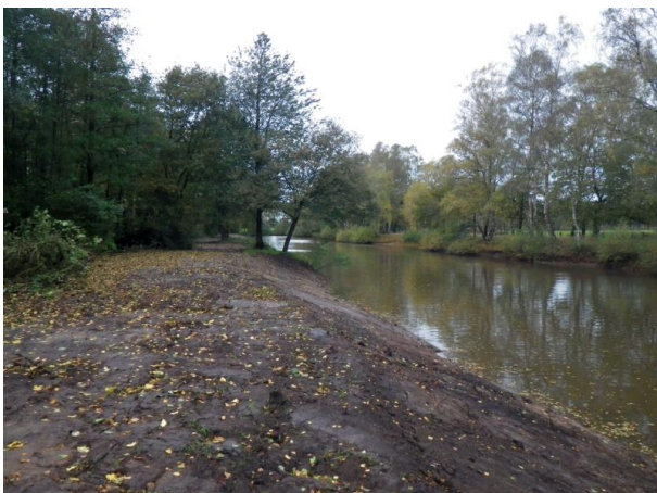
südlicher Bauabschnitt Böschungsgestaltung ehemalige Neophytenflur
