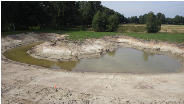
nördlicher Bauabschnitt Blänke
